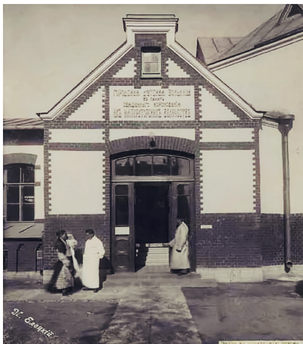
Рис. 18. Вход в амбулаторию
