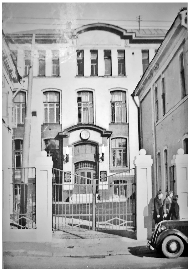
Рис. 3. Здание Первой московской зубоврачебной школы на Долгоруковской улице
