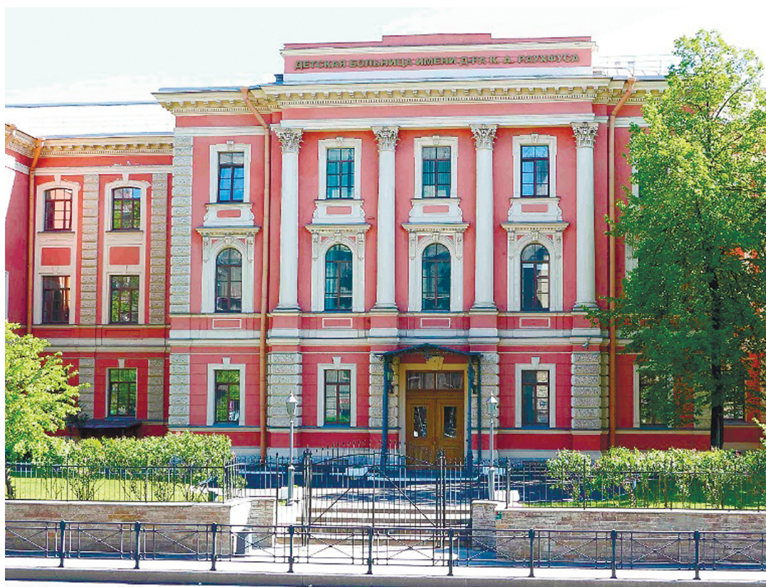
Рис. 25. Главный фасад здания Детской больницы им. доктора К.А. Раухфуса. Современный вид [57]
