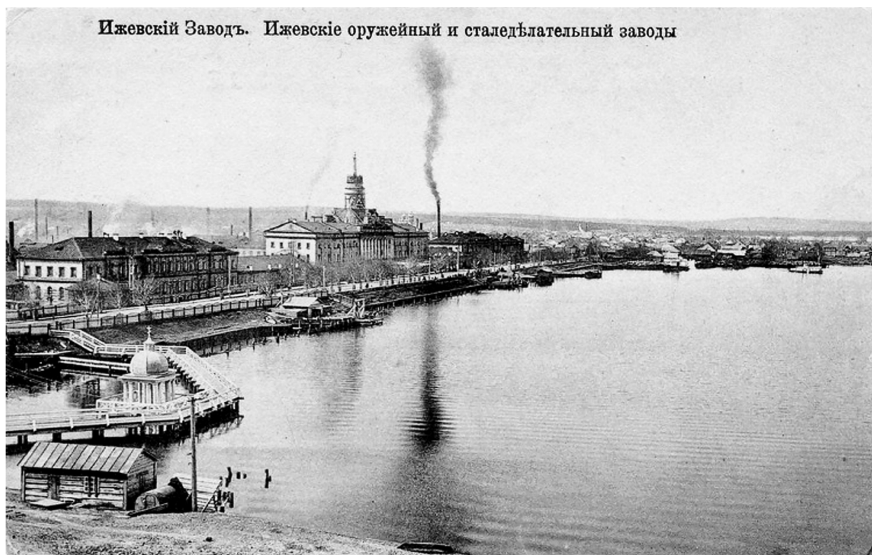
Рис. 1. Плотина Ижевского оружейного завода
