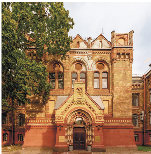
Рис. 22. Внутренний двор здания Александровского женского приюта [47]
