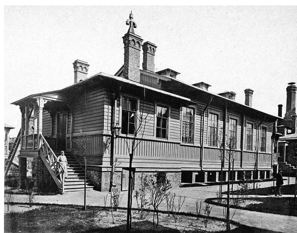
Рис. 13. Больница Санкт-Петербургского Биржевого купечества в память Александра II. Деревянный барак [30]
