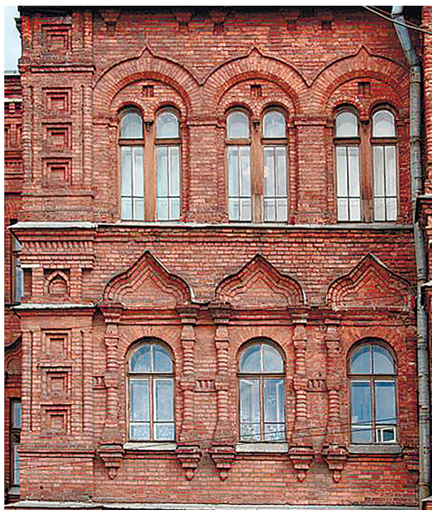
Рис. 4. Оформление окон центрального ризалита здания Волковской купеческой богадельни [12]
