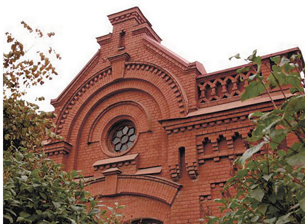
Рис. 7. Больница Обуховского завода. Фронтон бокового ризалита [17]
