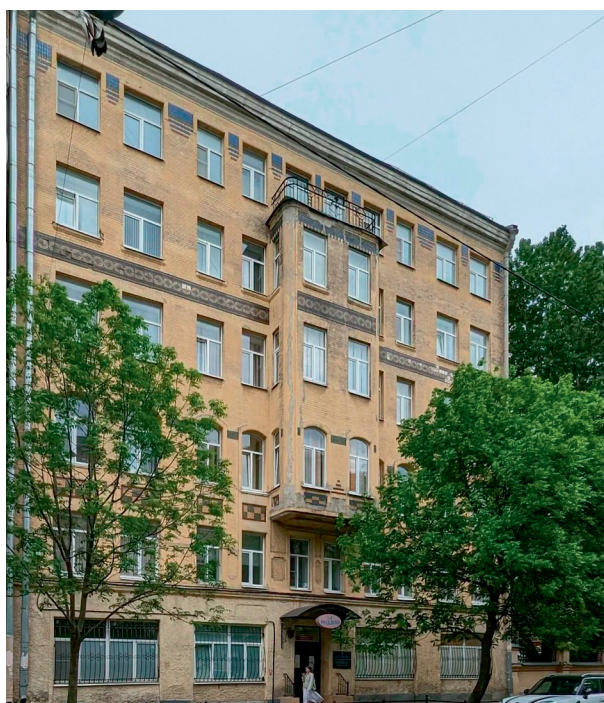
Рис. 24. Здание родильного дома № 1 [22]
