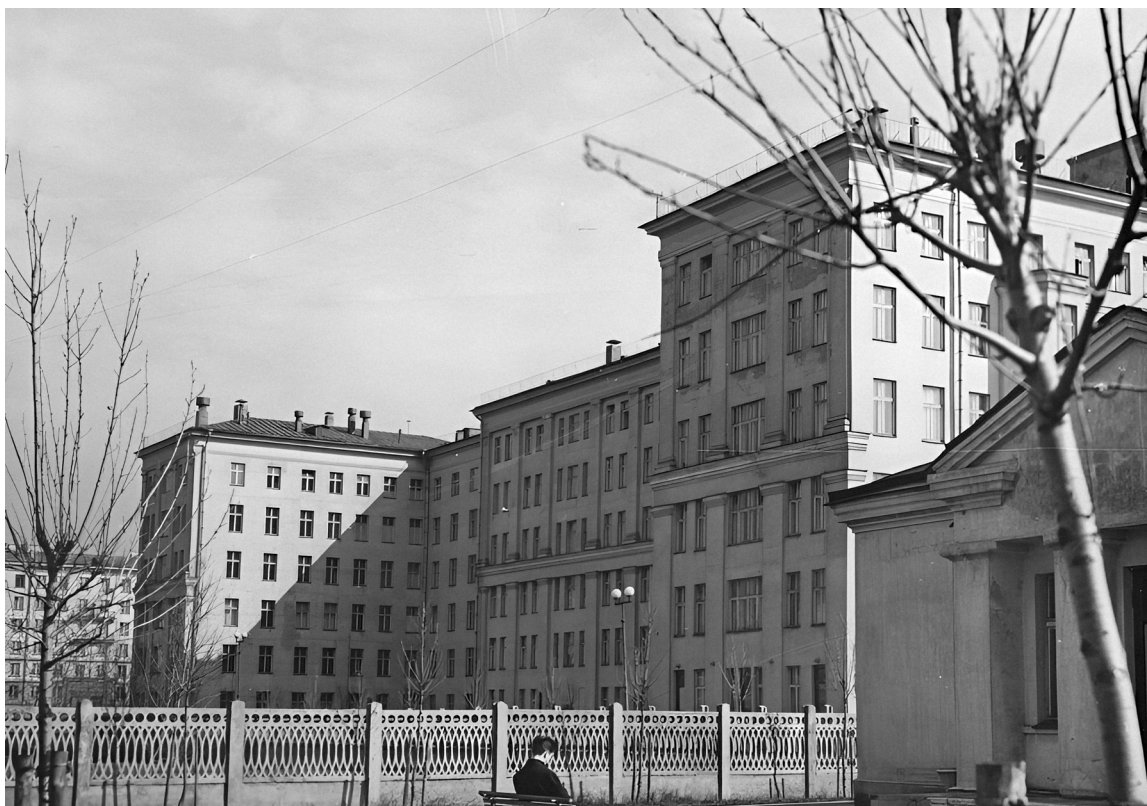
Рис. 38. Объединенная больница № 2 Московского района [61]
