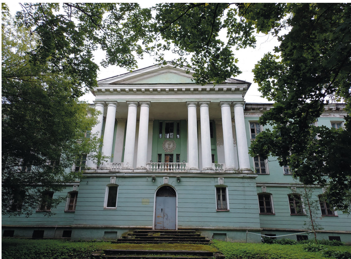
Рис. 27. Медико-санитарная часть № 1 завода имени М.И. Калинина. Фрагмент фасада. Центральный ризалит. Фото: Л.Н. Лисенкова
