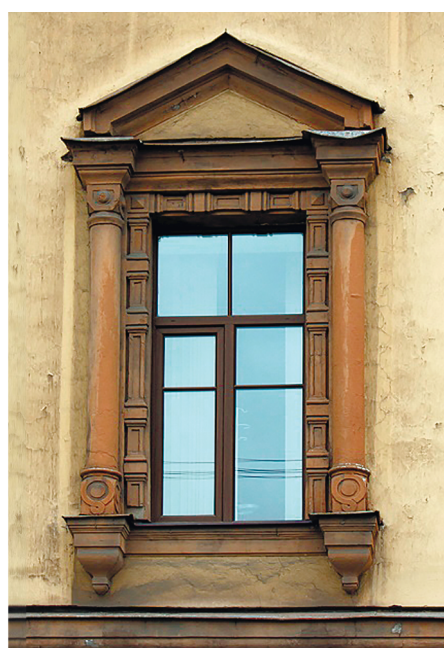
Рис. 12. Элементы оформления оконных проемов второго этажа здания Крестовоздвиженской общины сестер милосердия [57]
